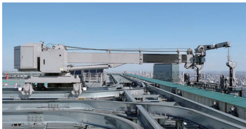
▲アームを伏せた状態。アーム基部を台車前部に配置し、目立たず格納できます
