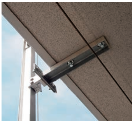
▲ ベランダ軒天へのアンカー固定
