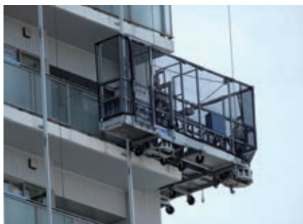
▲ KER(L型)使用による施工例
