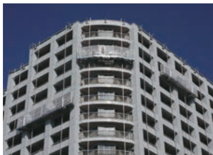
▲ KER(U型)使用による施工例
