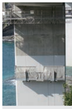
橋脚 (ゴンドラシステム)
