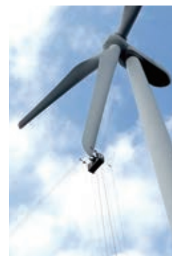
風車ブレード (ゴンドラシステム)
