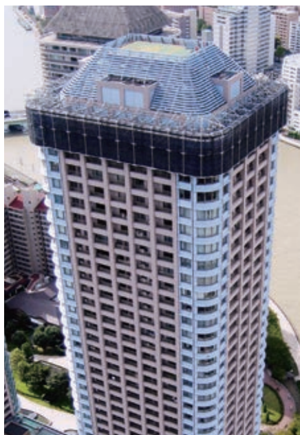
▲ 2フロアの同時施工も可能
