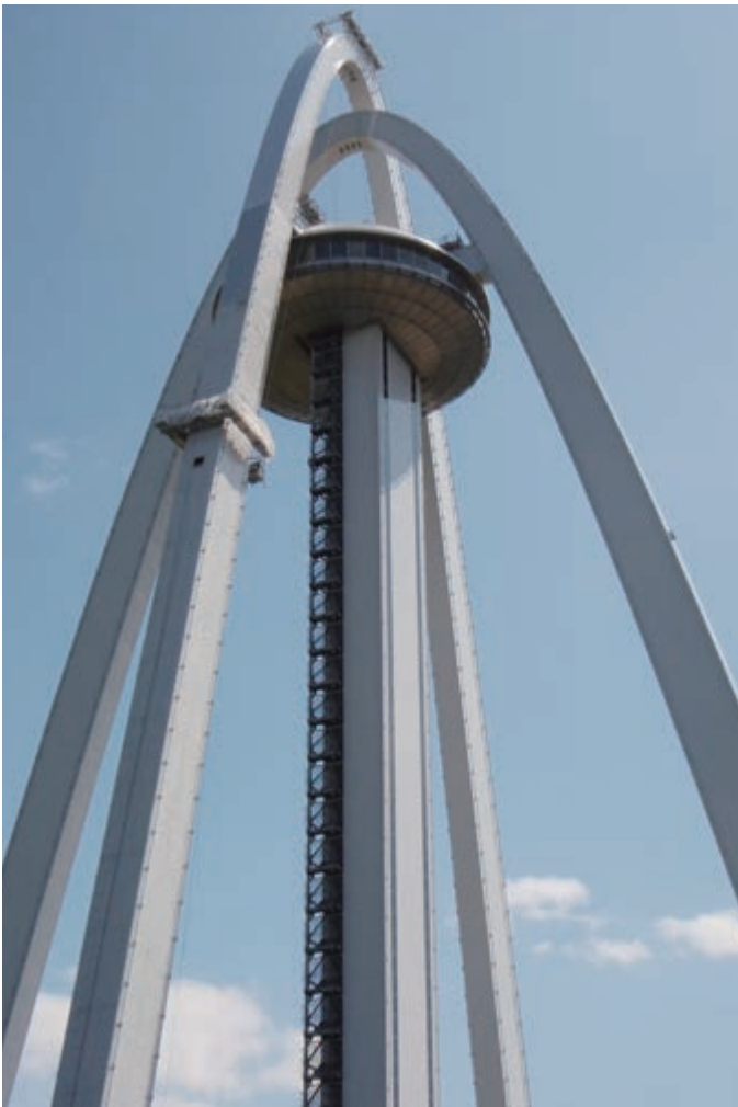
■ タワー改修工事用ゴンドラ
