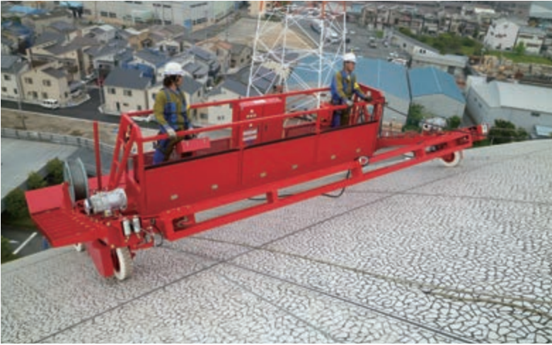
■ ドーム屋根工事用ゴンドラ
