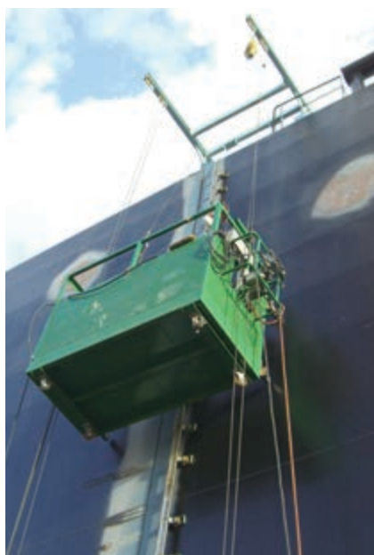
■ 造船工事に用ゴンドラ
