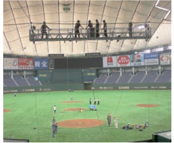
■ ドーム内メンテナンス用ゴンドラ
