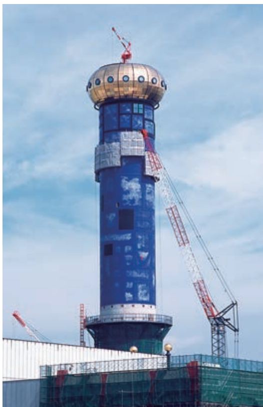
■ 煙突工事に用三段式ゴンドラ
