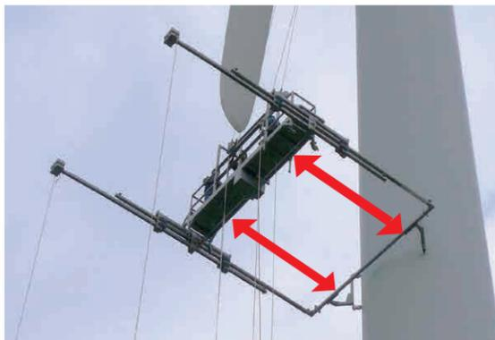
◀ ガイドには伸縮機能搭載。ブレードの高さまで上昇後、ガイドを伸ばすことでブレード部分まで移動できます。
